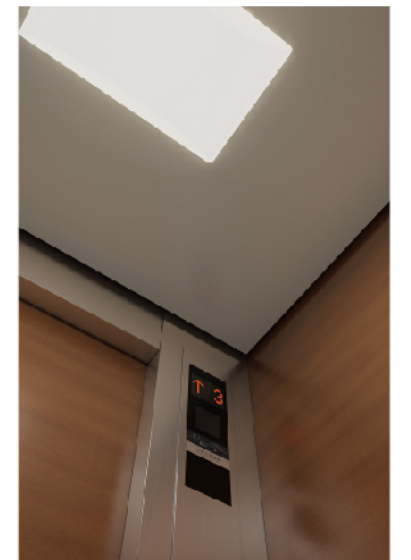
吊顶：涂装钢板 (Y033), 配乳白色亚克力灯罩 照明：中央照明
