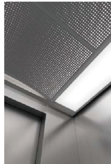
吊顶：中央拱形网状照明板+两侧乳白色亚克力板 照明：透光照明LED
